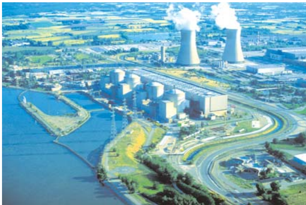
Les installations de Tricastin
